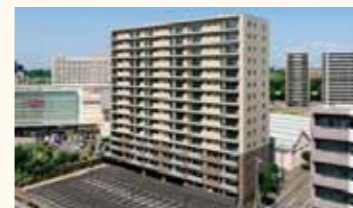
札幌：The Parkhouse 札幌桑园 (2014年竣工)
