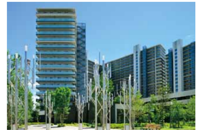
The Parkhouse 津田沼奏之杜 (2013 年竣工)
