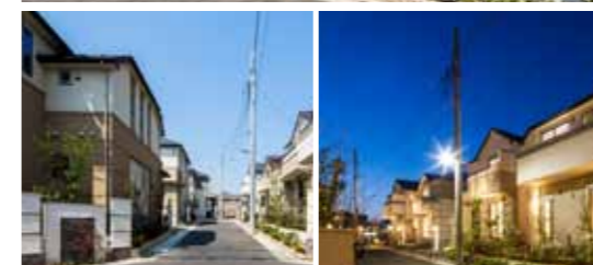
The Parkhouse STAGE 大泉学园 (2014 年竣工)
