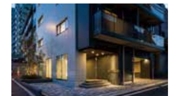
The Parkhabio 品川户越 (2016年竣工)
