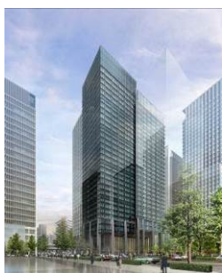
大手町連鎖型都市再生プロジェクト第3次事業
