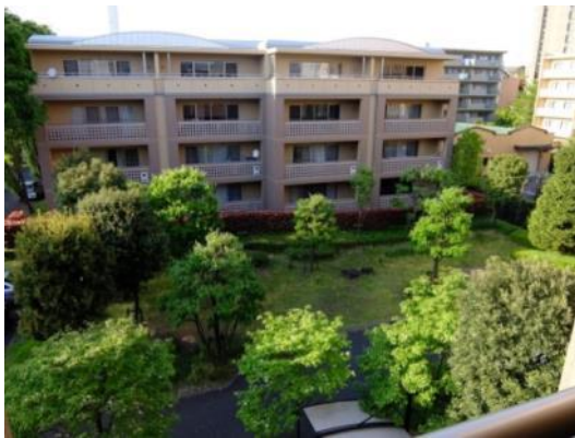
▲実験庭園俯瞰 (改修前)
