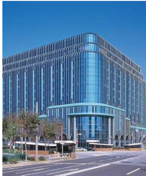
▲金沢パークビル (1991年竣工)
