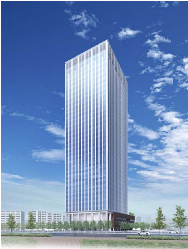
<新宿フロントタワー外観>
