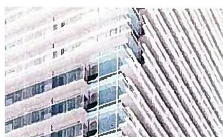
格子状スクリーンは、各バルコニー手摺の上端と下端に設けられた水平ルーバーによって構成され、遠方からは深く編みこまれた質感を与えます。更に住戸内部からの眺望も確保しながらも、垂直のメタルフィンを等間隔でルーバーの間から飛び出させて、水平ルーバーの強い水平性を対比させ、本体建物のファサードに変化をもたらしています。また、クラウン（建物頂部）のデザインにおいては、建物本体を包み込んでいるルーバースクリーンの関係が逆転し、透き通るガラスボックスの様な風よけスクリーンが特徴となっています。
