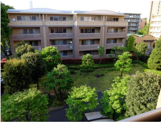
▲実験庭園俯瞰（改修前）
