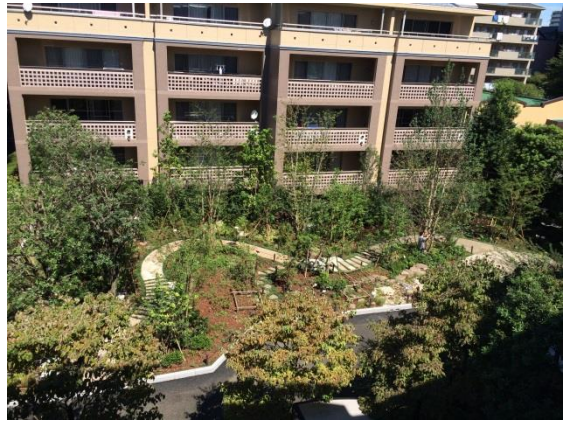
▲実験庭園俯瞰（改修後）
