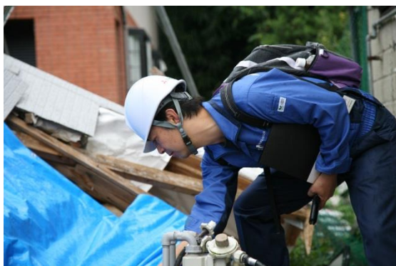
▲戸建被害状況の調査（益城町）
