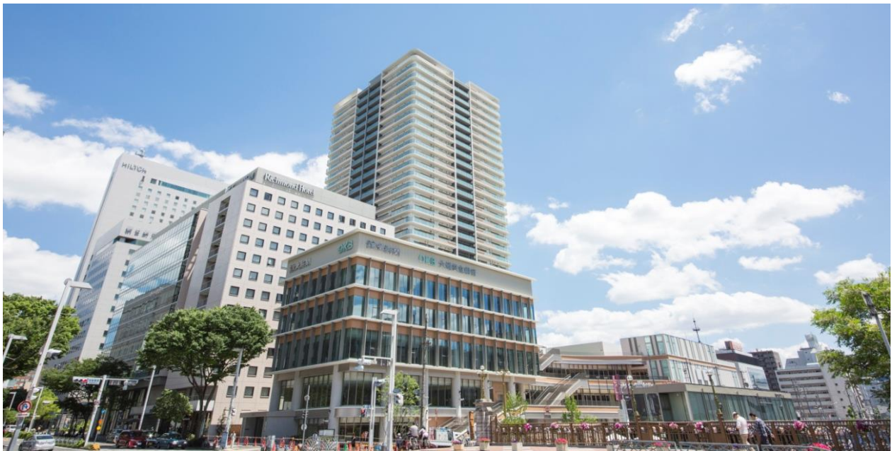
竣工写真：北西より区域全体を望む
