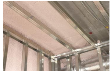
▲断熱材の折り返し施工
