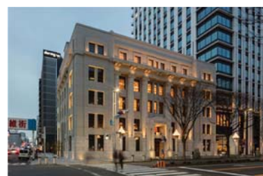
旧名古屋銀行本店ビル (THE CONDER HOUSE)
