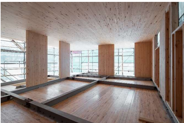
▲「Flat Mass Timber 構法」施工現場
