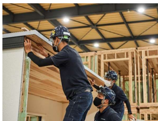
▲工場内での建設作業
