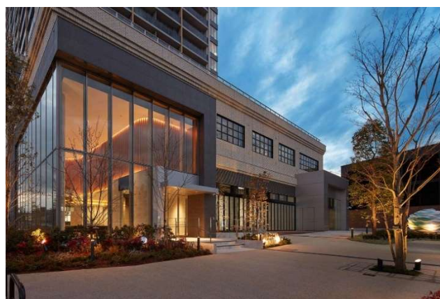
▲エントランス外観
