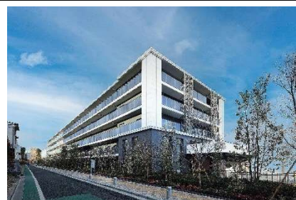
▲「Tonowa Garden 目白台」外観
